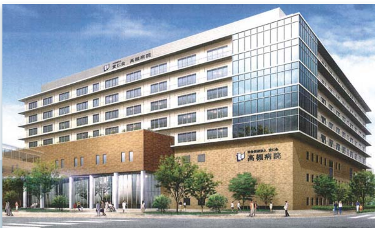
平成27年 新病院完成予定
